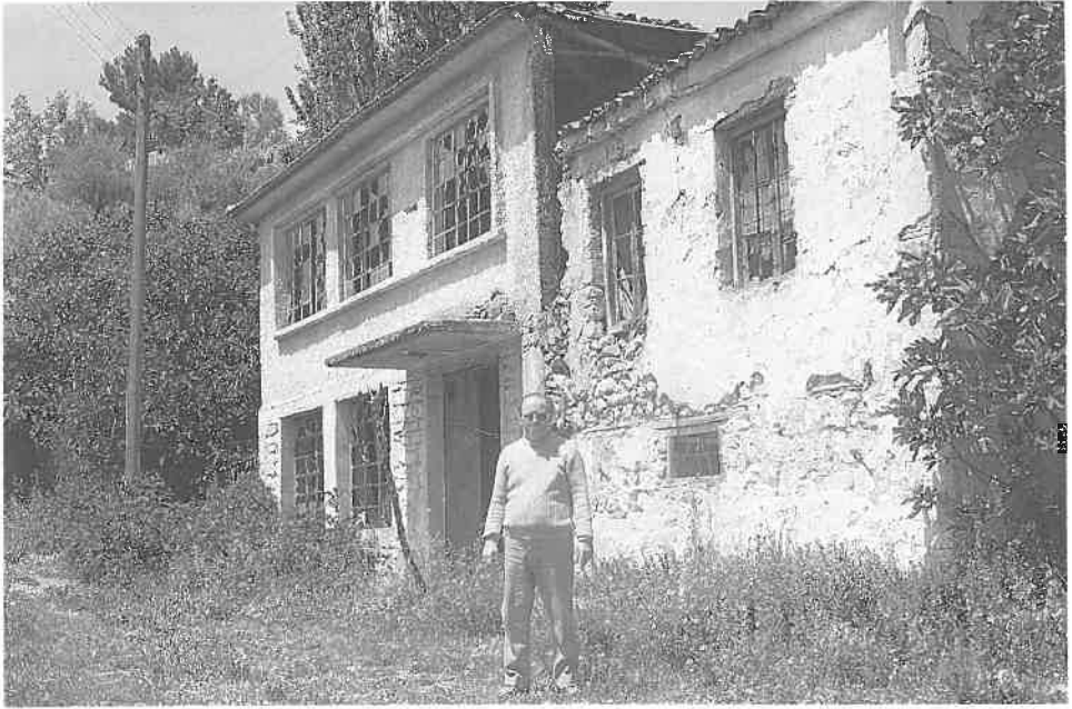
8. Τό κτίριο του μύλου τών αδελφών Μπαλαμότη.
