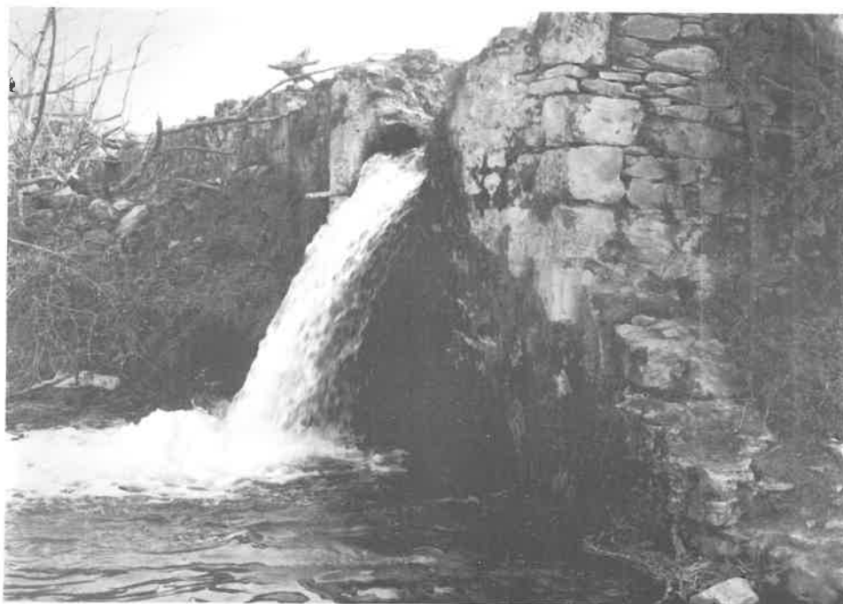
11. Ντριστελά. Τό τέρμα του άγωγού του νερού καί ή «κρέμαση τής νεροτριβής.
